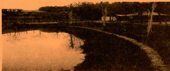
工事完了後の沈砂池
