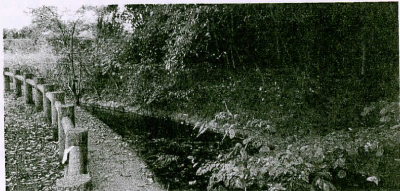
このコンクリート護岸が自然護岸に変わる
